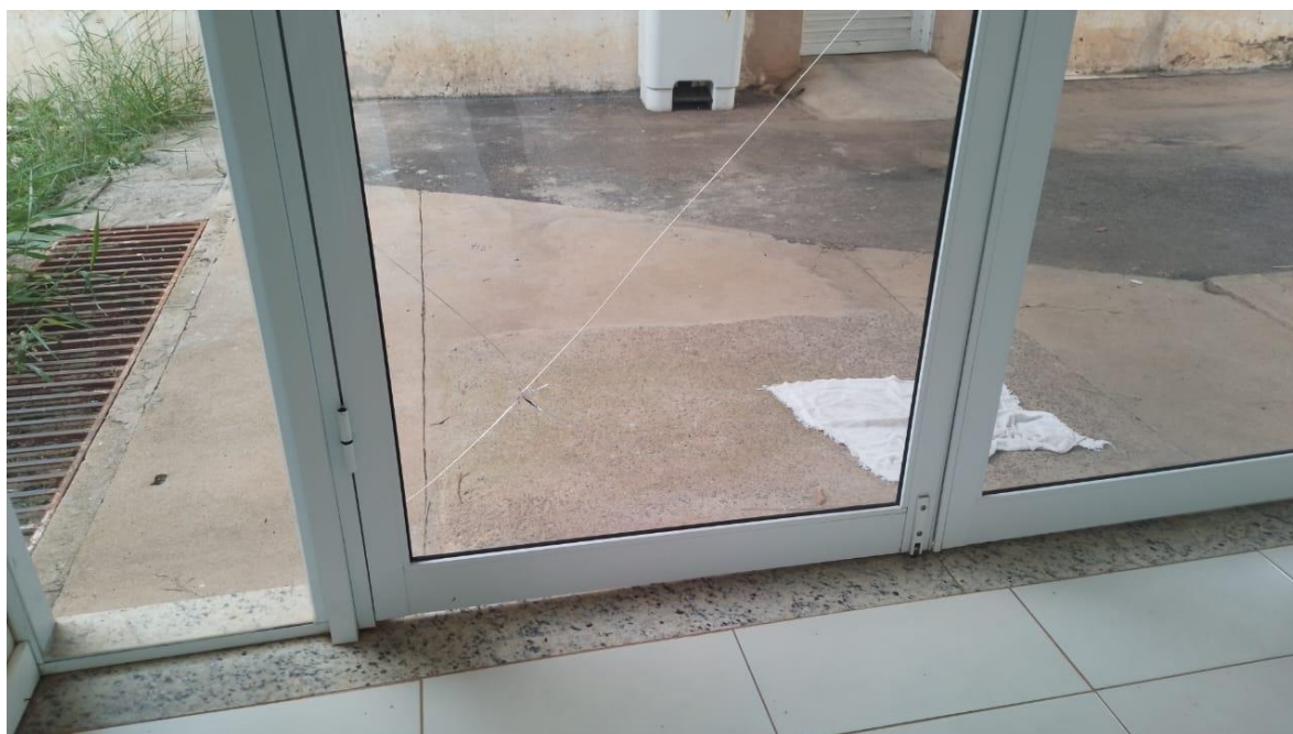
Figura 8 PORTA ACESSO AO LABORATÓRIO
