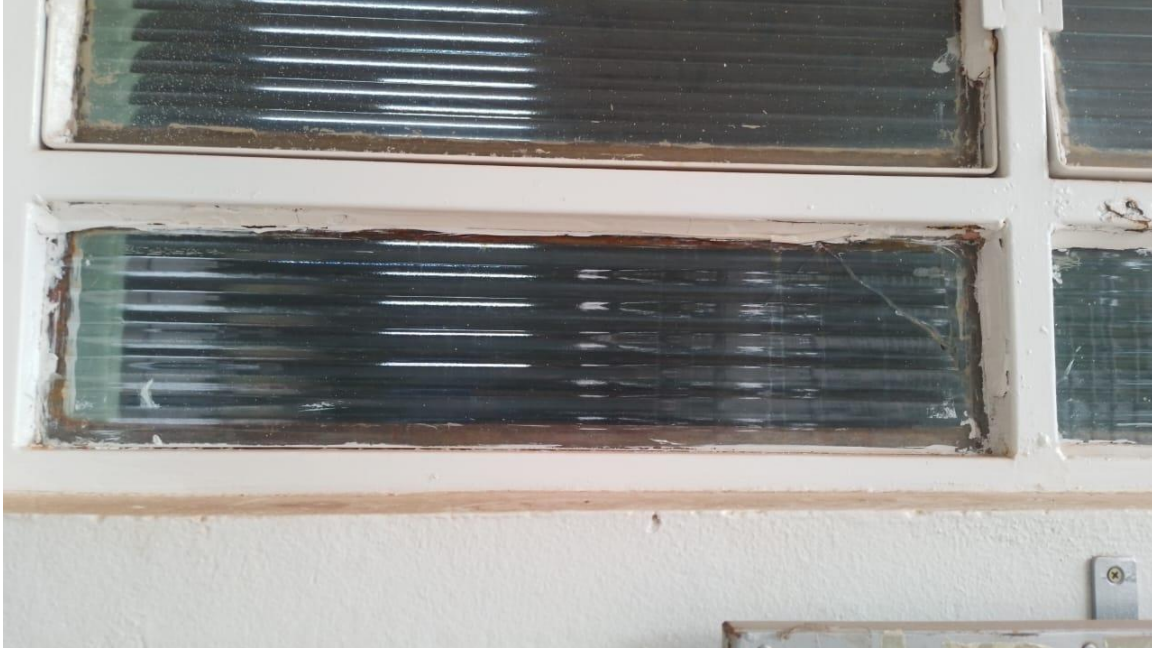
Figura 11 SALA DE ENFERMAGEM
