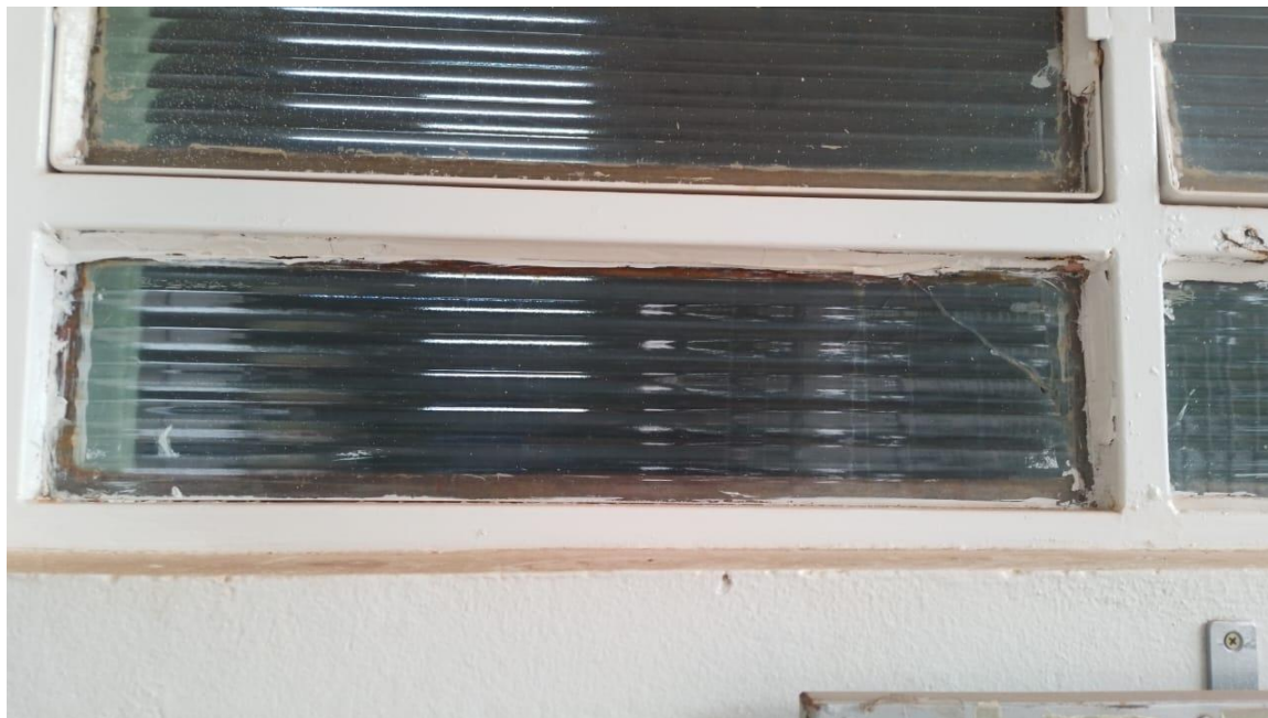
Figura 11 SALA DE ENFERMAGEM
