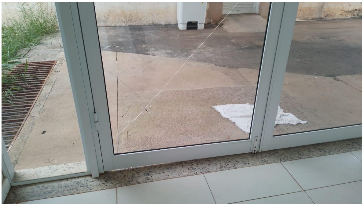
Figura 8 PORTA ACESSO AO LABORATÓRIO
