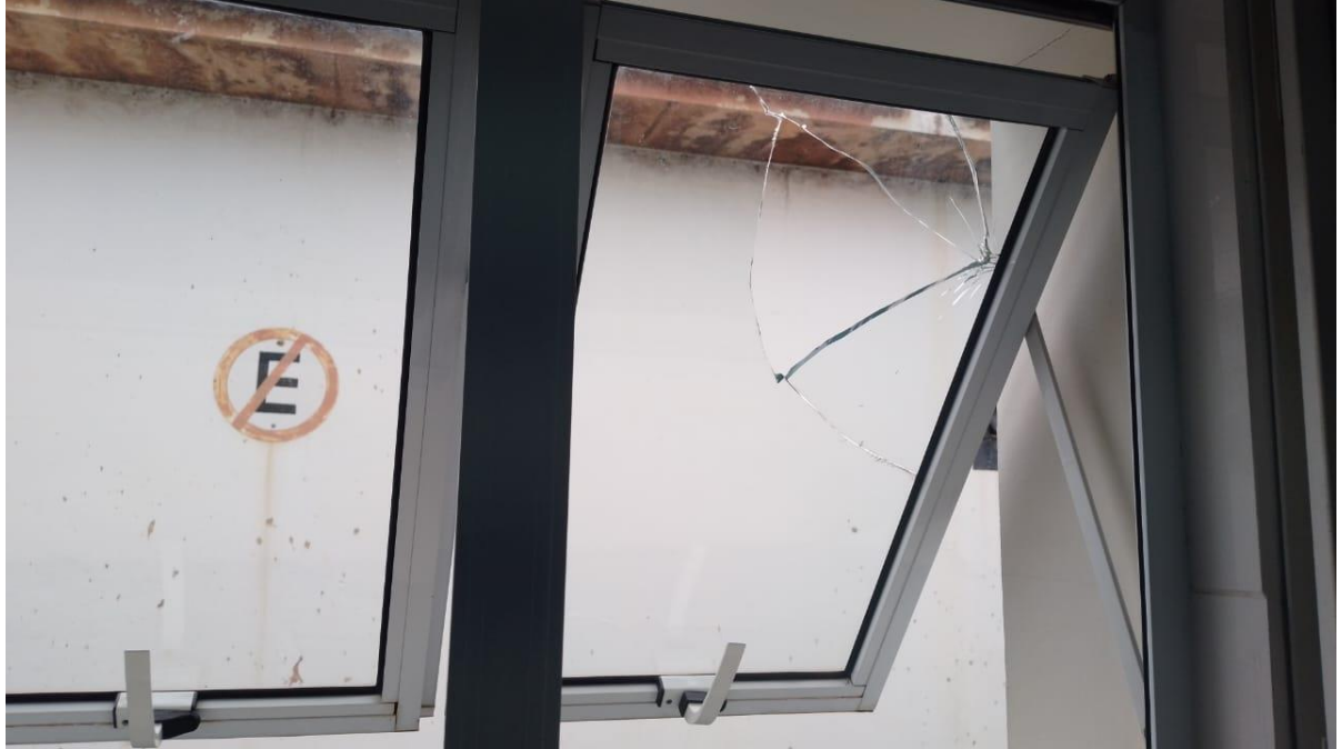
Figura 7 QUARTO 2 - INTERNAÇÃO HOSPITAL
