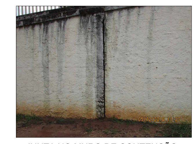
JUNTA NO MURO DE CONTENÇÃO COM 4 cm de ABERTURA
