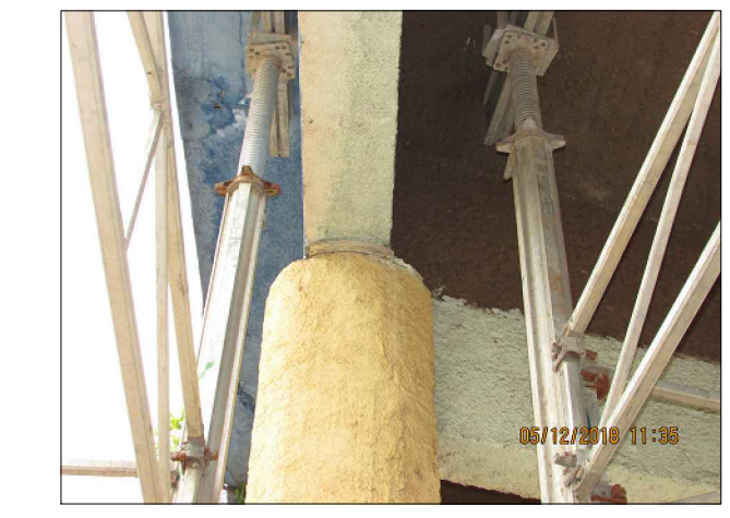
DETALHE DA MADEIRA ENTRE VIGA E PILAR
